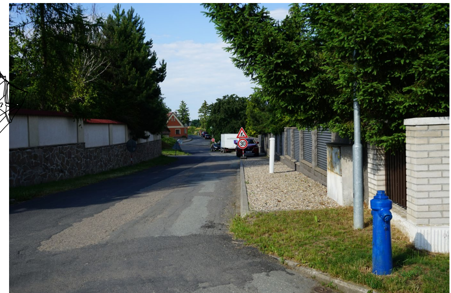
ulice zpřístupňující jihovýchodní část obce s travním pásem po jedné straně
