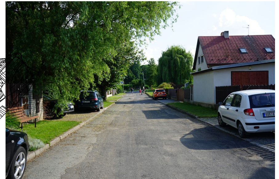
přístupová ulice se dvěma travnatými pásy a chybějícím chodníkem
