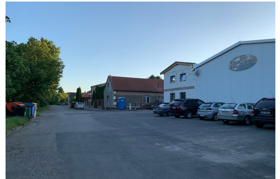
neadekvátní pojetí budovy i zpevněné plochy
