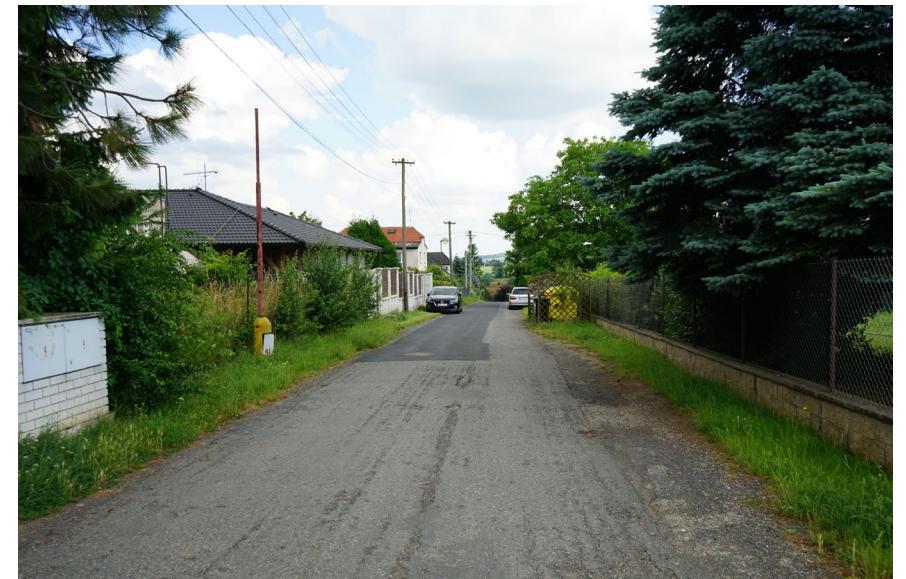
část ulice bez chodníku se zatravněnými pruhy
